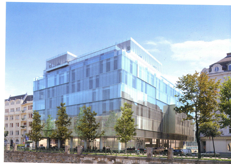
▲ Umbau der ehemaligen Bank Austria Zentrale Vordere Zollamstraße
