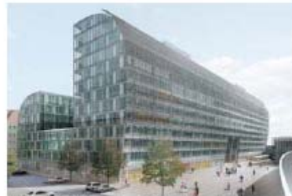
Beim Officecenter Rivergate am Handelskai hat sich das Baumanagement Nachhaltigkeit als Ziel gesetzt
